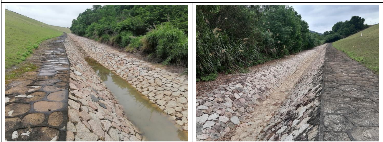
抽检当天排水、导渗系统图示
