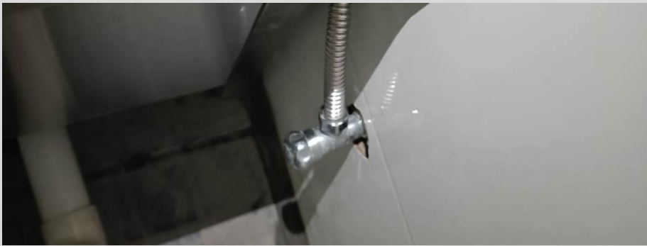
单星盆台连拖把池给水波纹管
