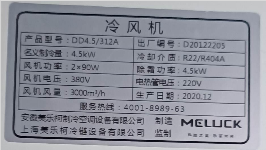
冷库压缩机组及冷风机铭牌
