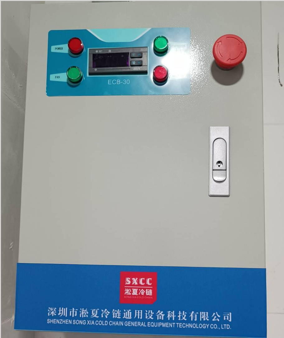
冷库压缩机组及冷风机控制箱
