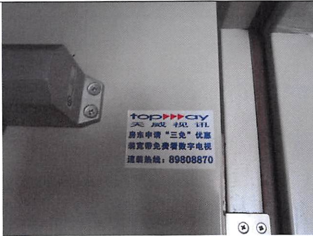
1. A座15楼消防门上有乱贴现象
