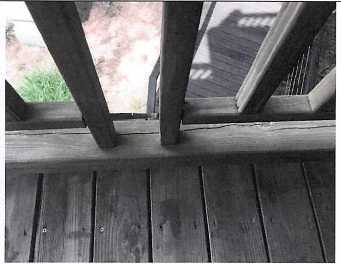
4. 凤塘河廊桥木地板面漆有脱落
