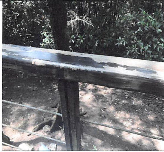
3. 凤塘河廊桥扶手护栏面漆有脱落
