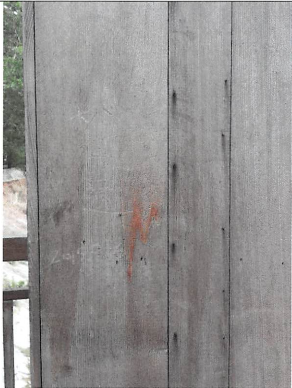
3. 凤塘河廊桥扶手护栏面漆有脱落
