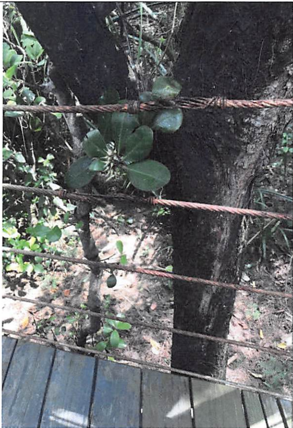
11. 钢丝绳木扶手护栏钢丝有明显锈迹
