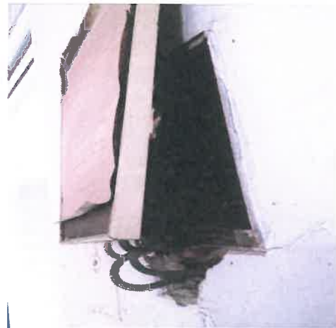
电源接口暴露在外
