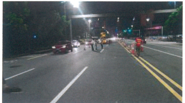
现场测试照片——临时封闭道路测试照度
