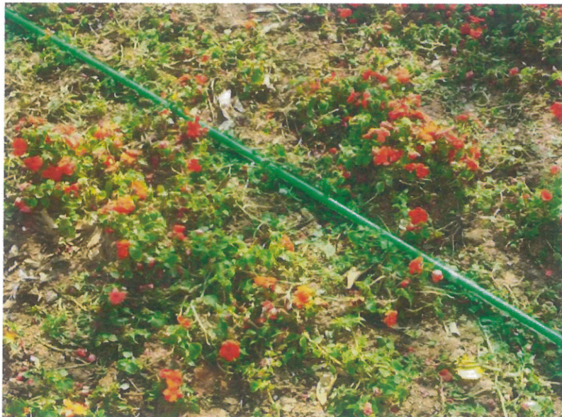
图 5 电缆铺设 (绿地)
